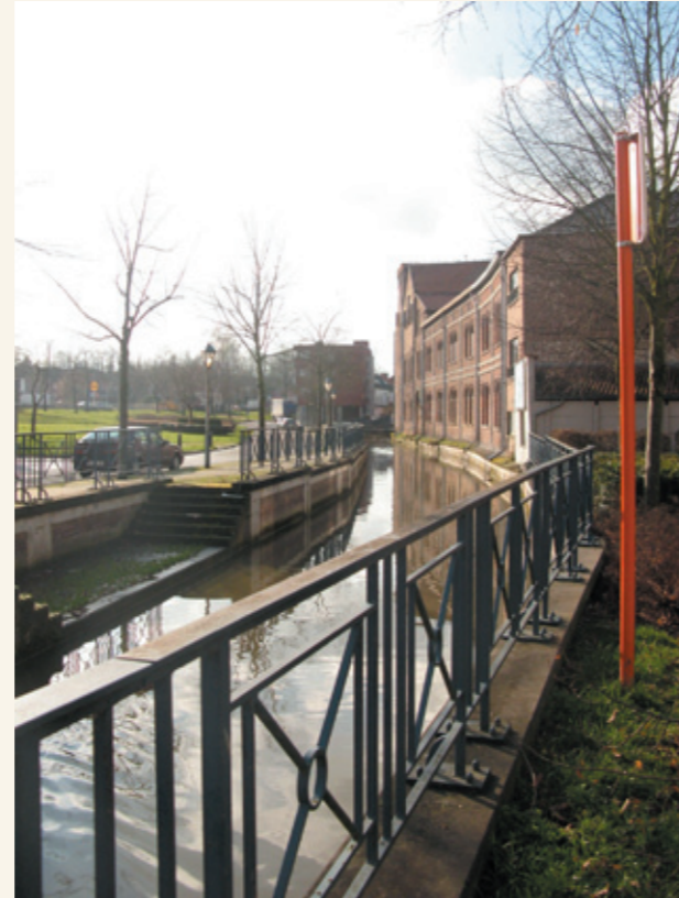
De Gete met de brouwerijgebouwen. Oorspronkelijk Vandenschrieck
